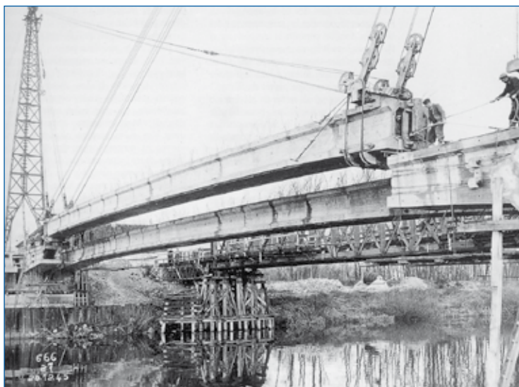
Montage de la partie centrale du cintre de l'un des viaducs de Caracas (E. Freyssinet, Un amour sans limite , p. 123).
