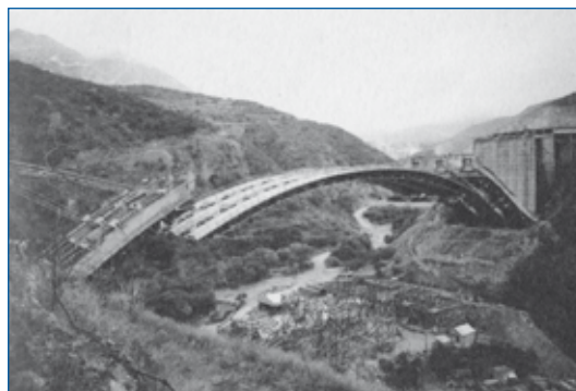
Montage de la partie centrale du cintre de l'un des viaducs de Caracas (E. Freyssinet, Un amour sans limite , p. 123).
