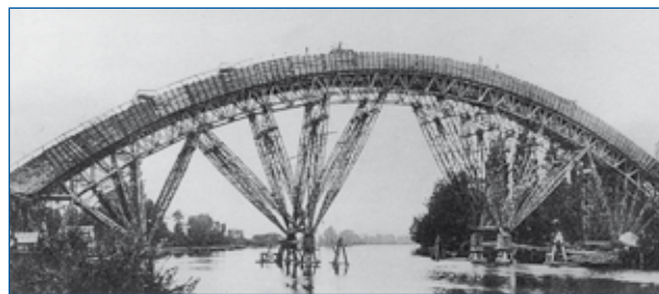
Le cintre de Saint-Pierre-du-Vauvray supportant le coffrage (B. Marrey, Les ponts modernes, 20e siècle , p. 58).
