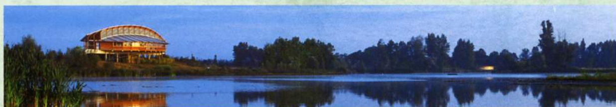
▲ Construit sur la berge, "l'écopôle" en bois, de forme organique, repose sur un portique en béton.
