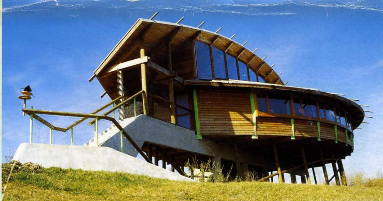
▲ Construit sur la berge, "l'écopôle" en bois, de forme organique, repose sur un portique en béton.
