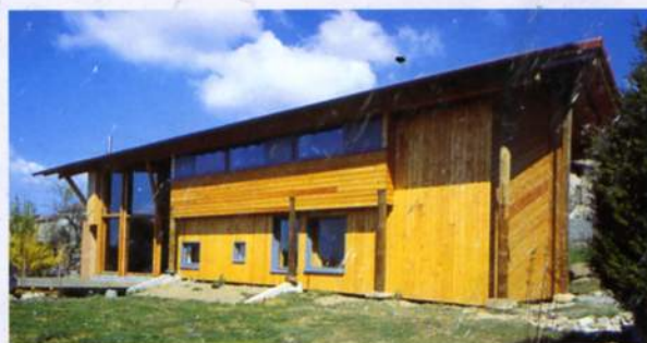
➍ Façade nord : une structure en parpaings recouverte d'un bardage en mélèze.
