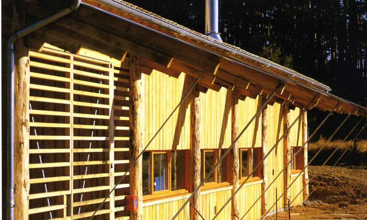
▲ Éléments structurels en saillie sur les façades latérales : piliers en bois écorcé, arbalétriers, tirants.
