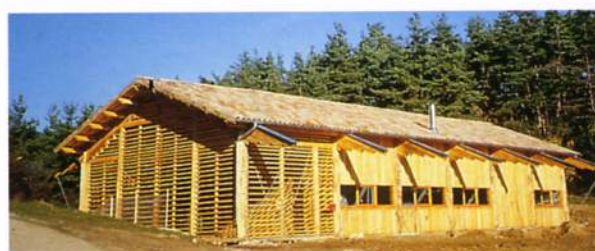
▲ Le revêtement extérieur, à claire-voie ou en bardage à lames verticales, est en mélèze non traité.
